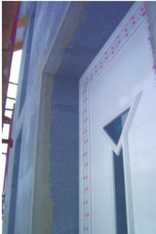
Zdjęcie 9.2. Ściana docieplona warstwą izolacji gr. 34 cm
