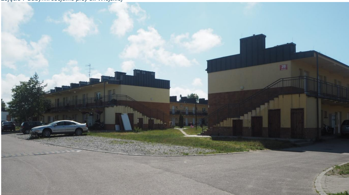
Zdjęcie 7 Budynki socjalne przy ul. Wiejskiej
