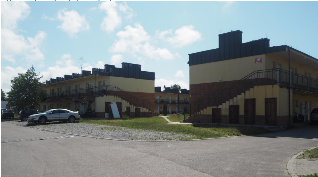
Zdjęcie 7 Budynki socjalne przy ul. Wiejskiej
